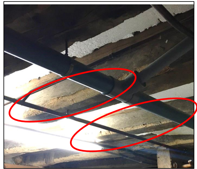
Traces d'attaques d'insectes
