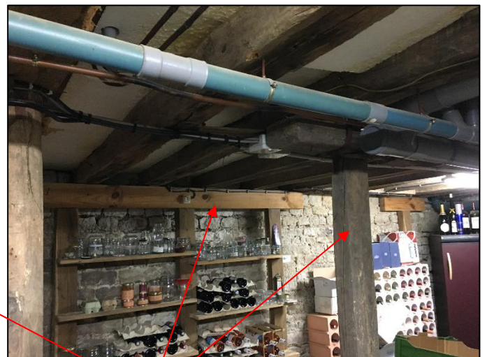
Portiques bois renforcés à mi-travée et sur appuis
